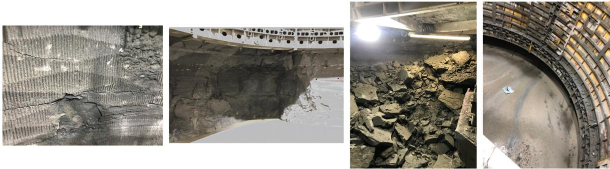
**Abbildung 11: Verbrauch der Schachtwand unter dem Gefrierabschnitt in Schacht 2 Anfang März 2019**
