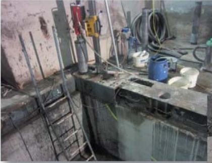
Werkzeug zum Aufräumen der Bohrlochwandungen im Maschinenfundament
