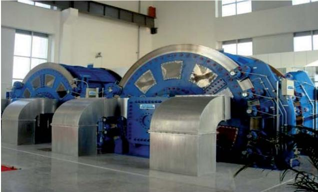
**Abbildung 2: Praxis - Fördermaschinen mit integriertem Motor**
