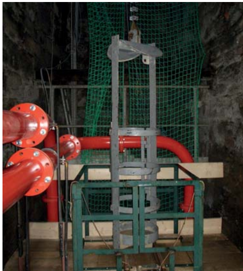
Abbildung 5: Rettungsgestell oberhalb der Arbeitsbühne auf der Hängebank
