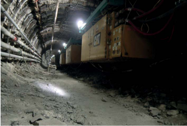
Abbildung 19: Abgesetztes Umrichtersystem in einer Abbaustrecke [Fa. Caterpillar Global Mining]
