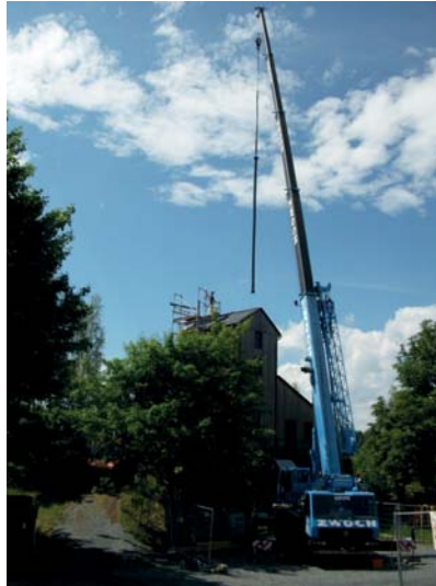
Abbildung 6: Einsatz des Mobilkranes bei der Rohrinstallation
