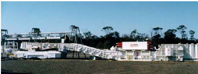
Abbildung 21: Streckenförderer im übertägigen Probeaufbau [Fa. Caterpillar Global Mining]
