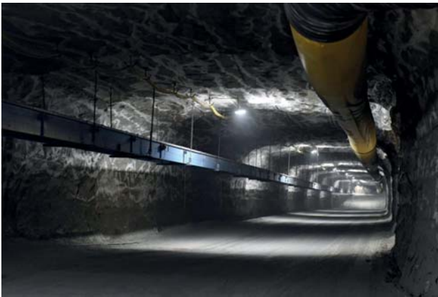
Abbildung 4: Neuerrichtetes Teilstück der Bandanlage
