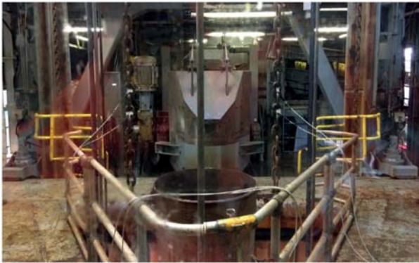
Abbildung 8: Messketten am Einlauf Fallrohr
