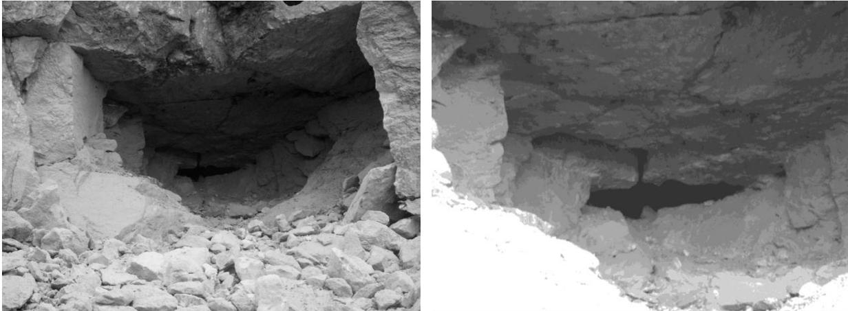
Abbildung 10: Gangförmiger Einbruch entlang des Bohrlochs
