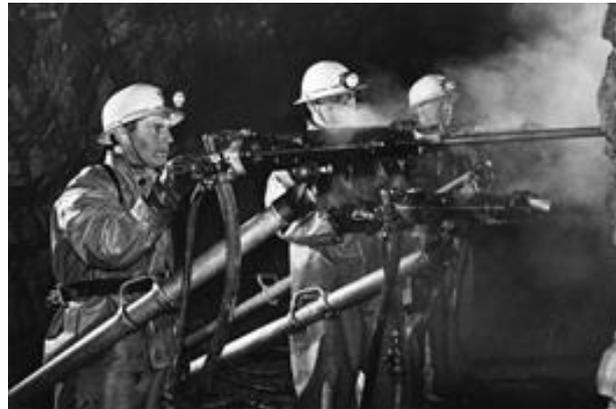
Abbildung 1: Druckluftbohrhämmer mit Bohrsäulen im Vortrieb
