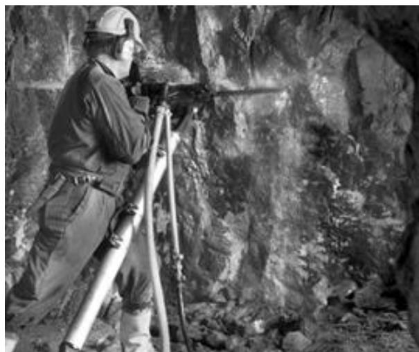
Abbildung 2: Die „Schwedische Methode“, ein Mann pro Bohrhämmer
