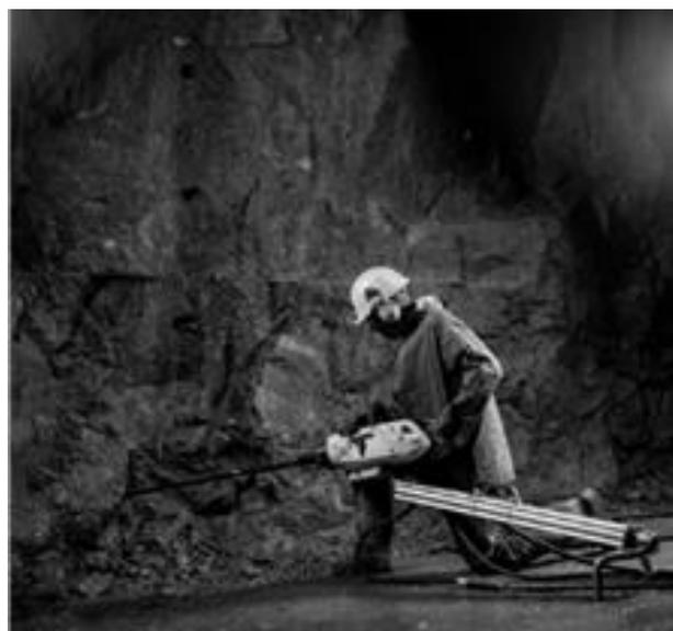
Abbildung 4: Handgehaltener hydraulischer Bohrhämmer mit Bohrsäule Foto: Atlas Copco
