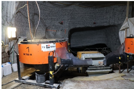
Abbildung 49: Übersicht über die eingesetzte Mischtechnik
