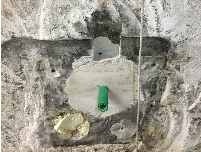
Abbildung 18: Verfüllte Bohrung B01-030 mit Kunststoffrohr und Baustoff
