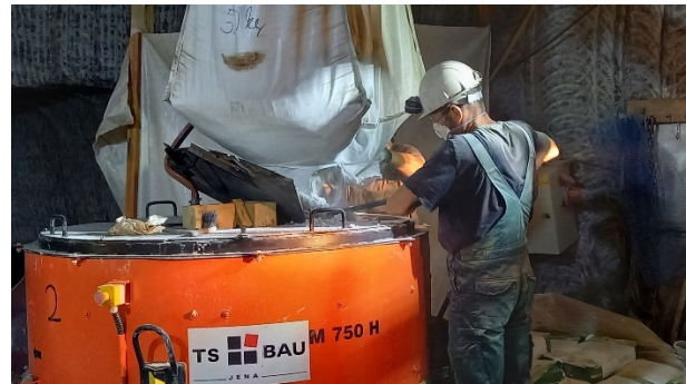
Abbildung 50: Befüllung des Zwangsmischers Filamos m 750 H mit Steinsalz
