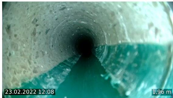
Abbildung 31: Ergebnis des Ausbohrens ohne eine zentrierte Führung der Bohrkronen
