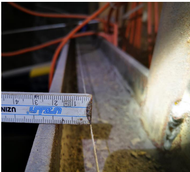
Abbildung 74: Mittige Durchbiegung des 3. I-Trägers
