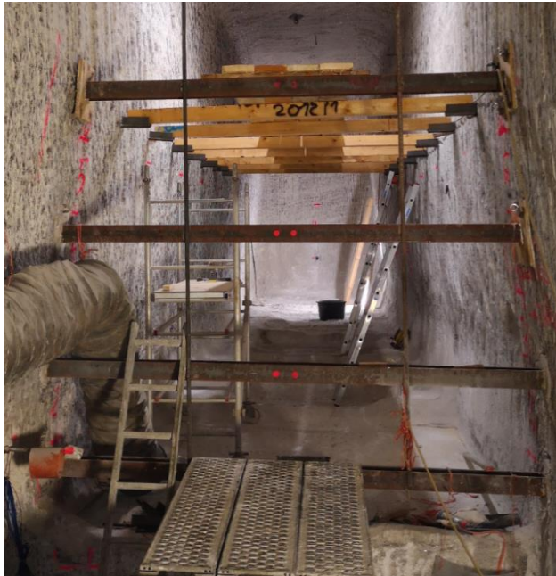
Abbildung 73: I-Träger der Schalung
