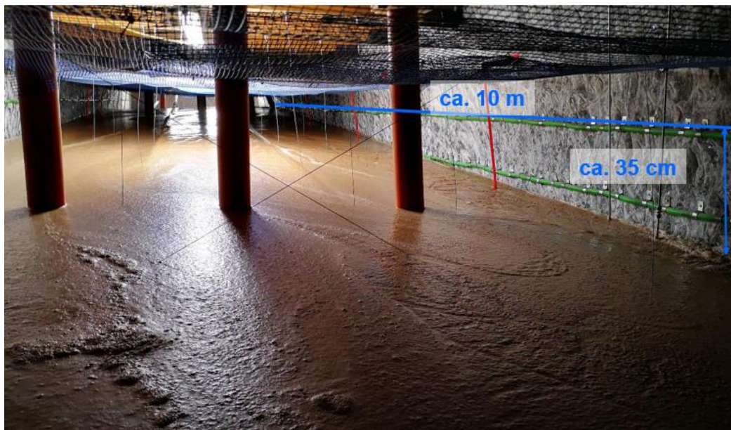
Abbildung 72: Stand der Betonage am Ende der Spätschicht am 27.07.2021 22:53 Uhr
