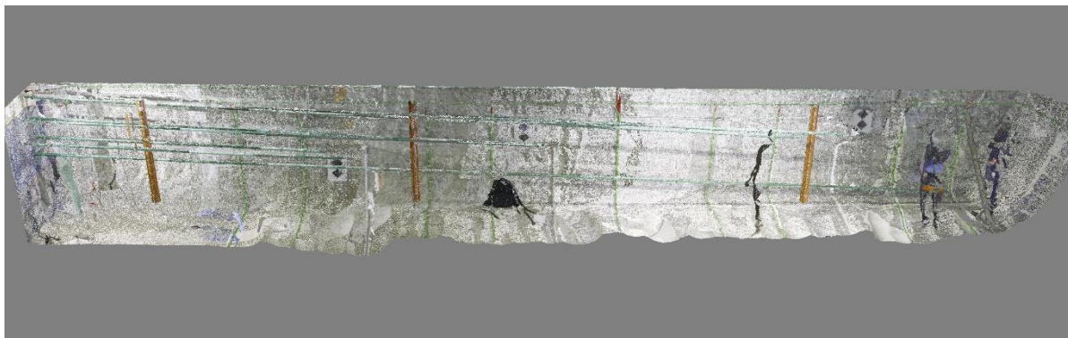
Abbildung 4: Seitenansicht des Hohlraumes
