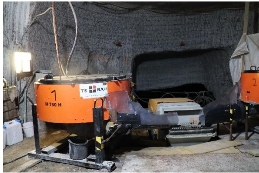
Abbildung 60: Übersicht über die eingesetzte Mischtechnik
